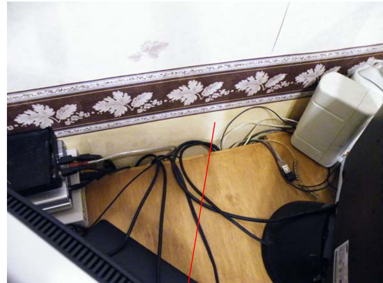
桌面電線統一由T 型桌端扁槽收入， 桌面清爽無電線
